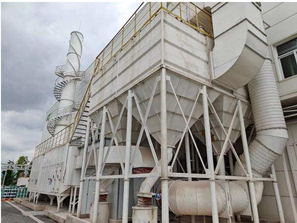
多彩真石质感车间废气除尘装置及排气筒
