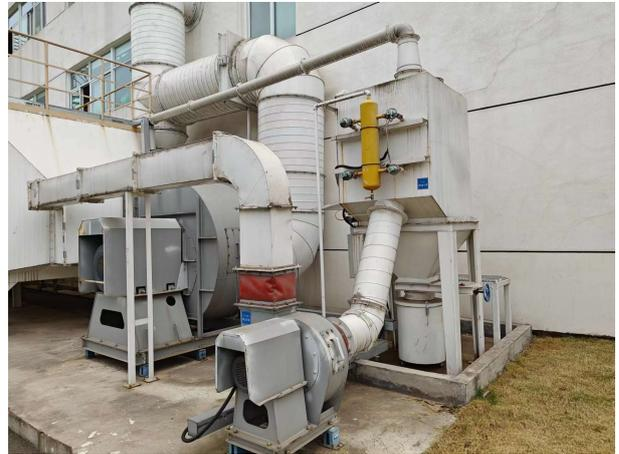
样板车间废气沉流式滤筒除尘装置
