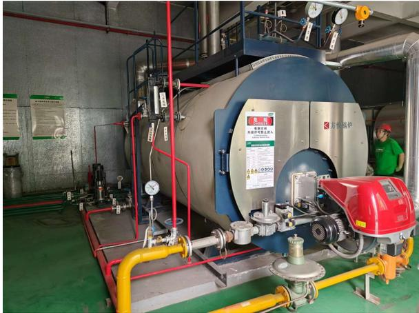
原有 1#锅炉低氮燃烧装置（以新带老）
