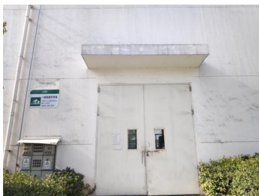
一般固废暂存间
