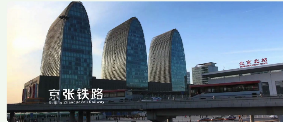
京张铁路沿线涂刷
