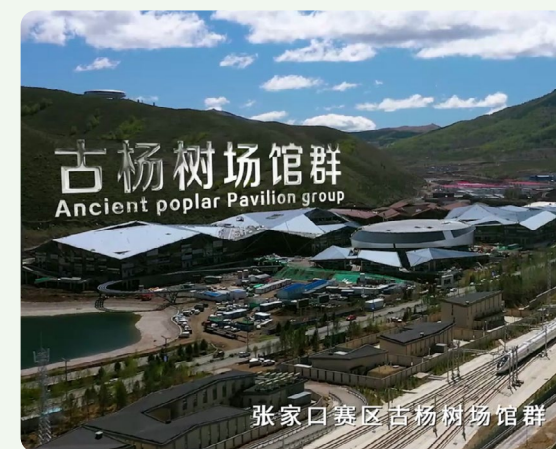
古杨树场馆群涂刷
