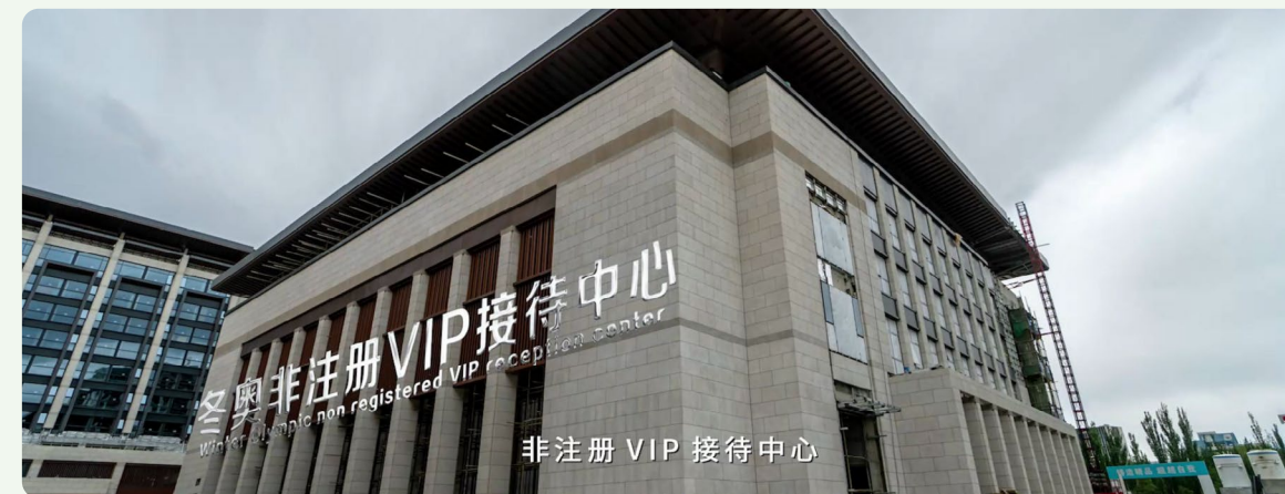
冬奥会非注册 VIP 接待中心涂刷
